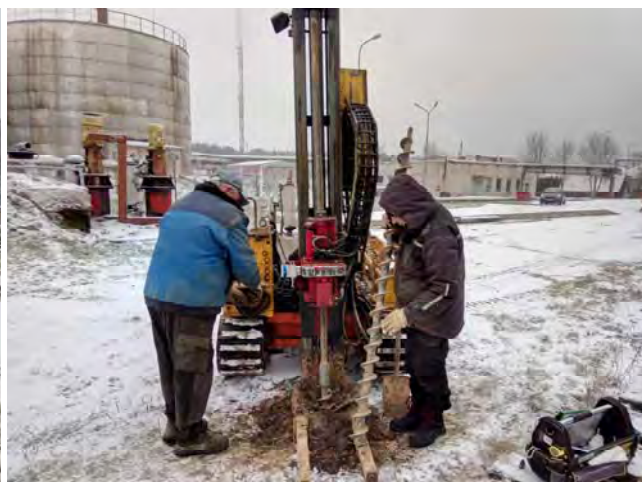
4 pav. Gręžinių gręžimas
