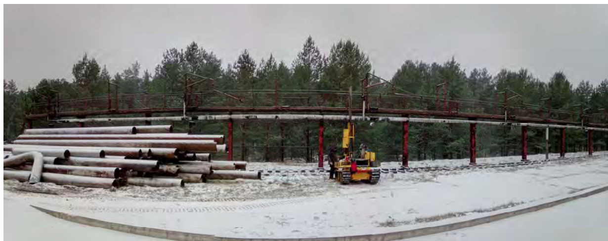
2 pav. Laikiniai sandėliuojami vamzdžiai bei už jų apleista estakada su tilteliu
